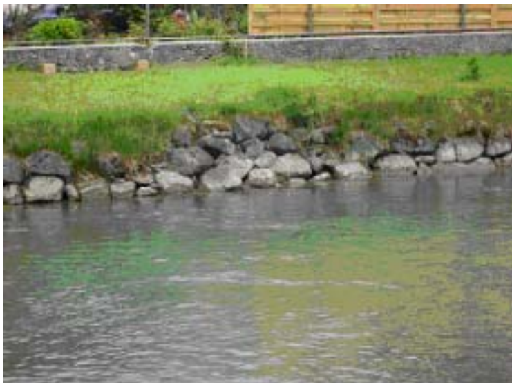
Abb. 3 Blockwurfverbauung am linken Ufer 230 m unterhalb des Ausflusses aus dem Sarnersee, Foto: J. Guthruf.
