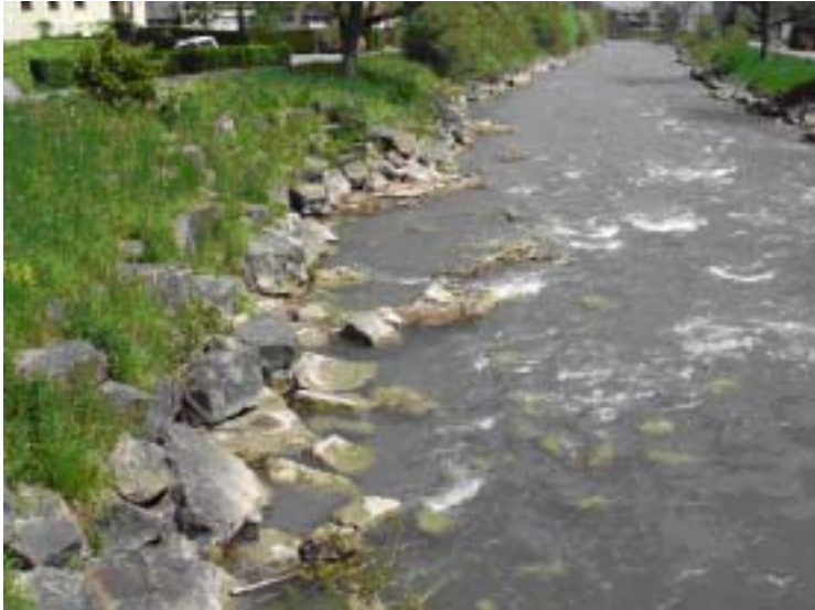
Abb. 4 Strukturierter Blockwurf unterhalb der Brücke Brünigstrasse, Foto: J. Guthruf.
