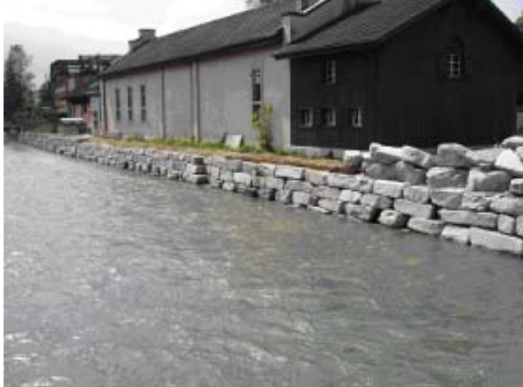
Abb. 2 Neue Blocksatzverbauung am linken Ufer unmittelbar oberhalb der Glaubenbergstrassen-Brücke, Foto: J. Guthruf.
