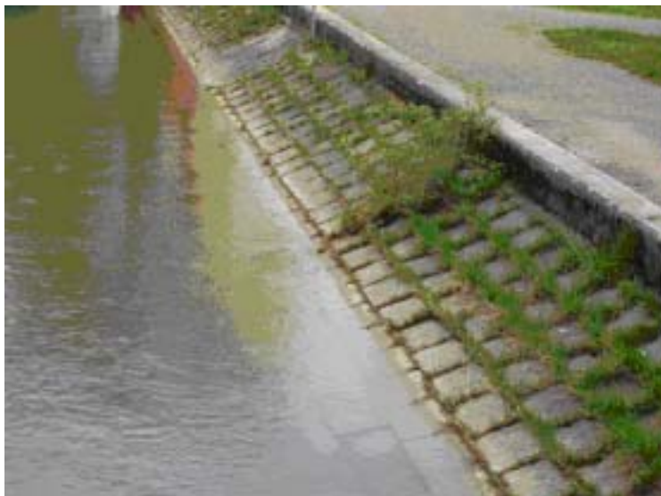
Abb. 1 Mit Mauerwerk gesichertes Ufer unmittelbar unterhalb des Ausflusses aus dem Sarnersee (rechtsufrig). Foto: J. Guthruf.
