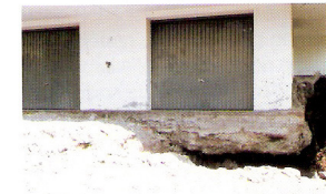
Mittelgründige Rutschung erfasst einen geringen Teil des Gebäudes
