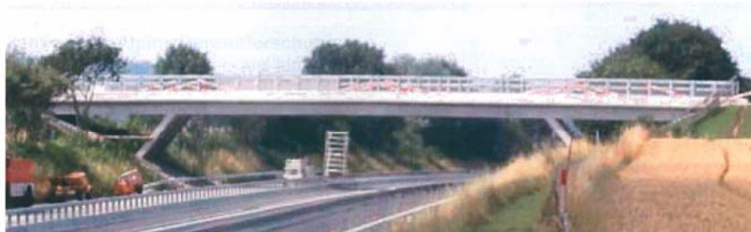
Bestehende Sprengwerkbrücken sind als erdbebensicher genug eingestuft.
