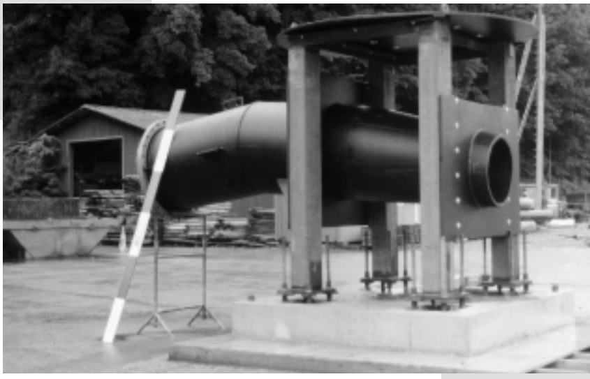
Die Auslaufdüse der Tiefenwassereinleitung vor dem Einbau 15 Meter unter die Wasseroberfläche des Alpnachersees
