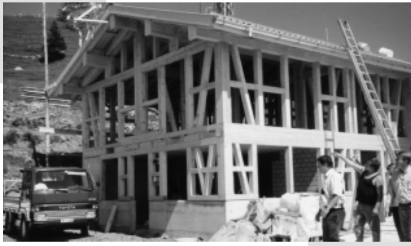
Neubau der Alphütte auf Dundelegg, Lungern
