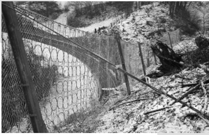
Steinschlagschutz A8 – Brünigstrasse bei Kaiserstuhl.
