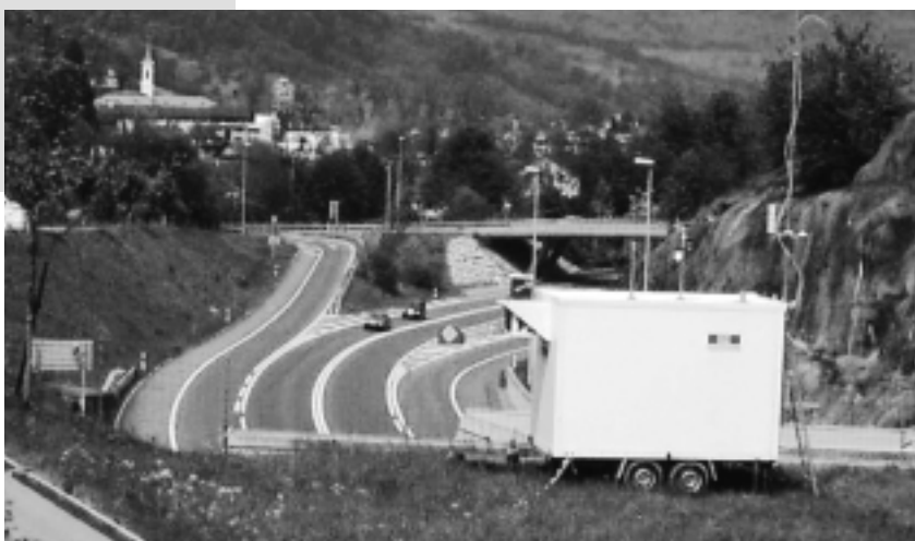
Messkampagne Tunnel Sachseln: Einsatz des Messwagens über dem Tunnelportal.
