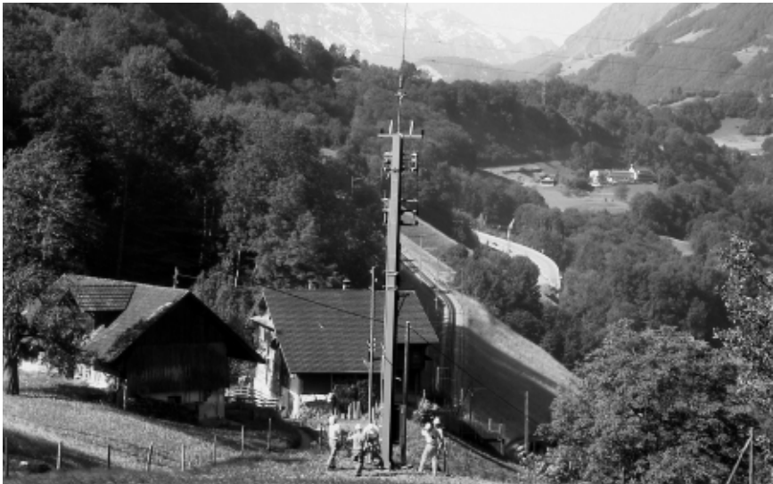
Bau der Stahlmast-Trafostation Ächerliberg, Giswil
