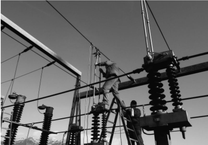
Revision von 50-kV-Schaltern und Trennern im Unterwerk Sarnen
