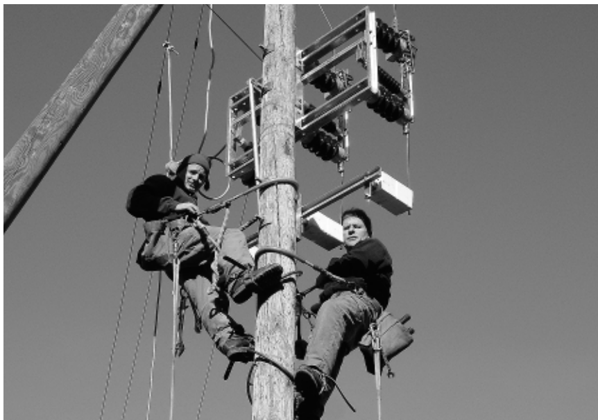
Montage Hochspannungsschalter
