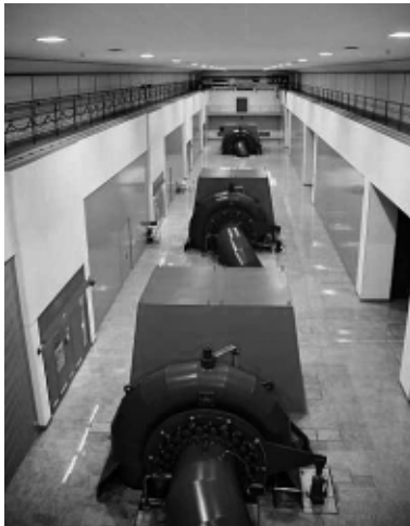
Kavernenzentrale Unteraa mit drei Francisturbinen
