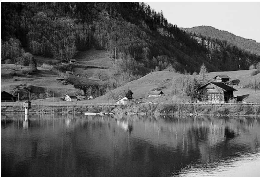
Das Kraftwerk Kaiserstuhl ist die älteste Kraftwerk-Zentrale des EWO
