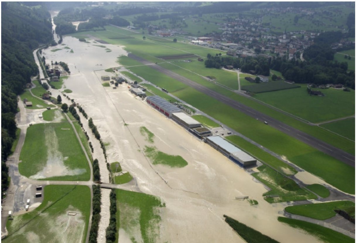
23.08.2005 – Alpnachdorf – Flugplatz Alpnach, Kläranlage
