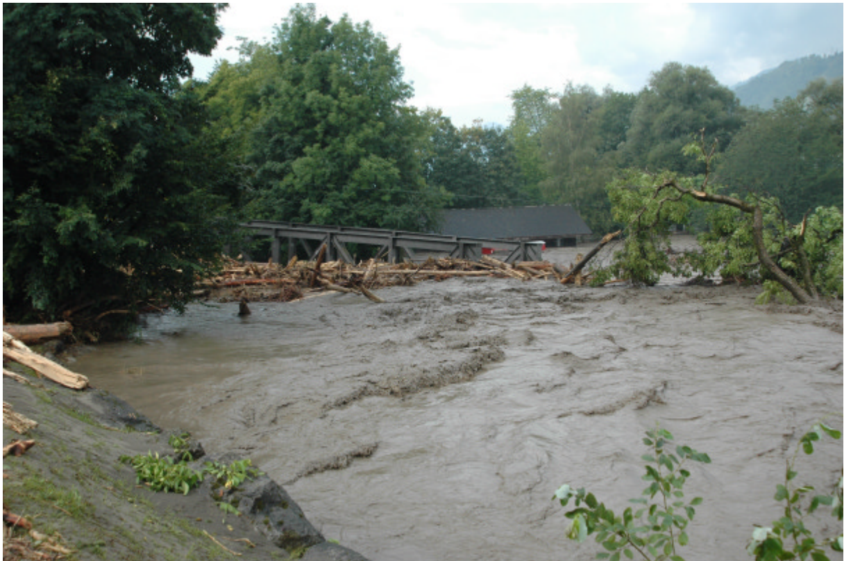
24.08.2005 – Sarnen – Seefeld, Eisenbahnbrücke
