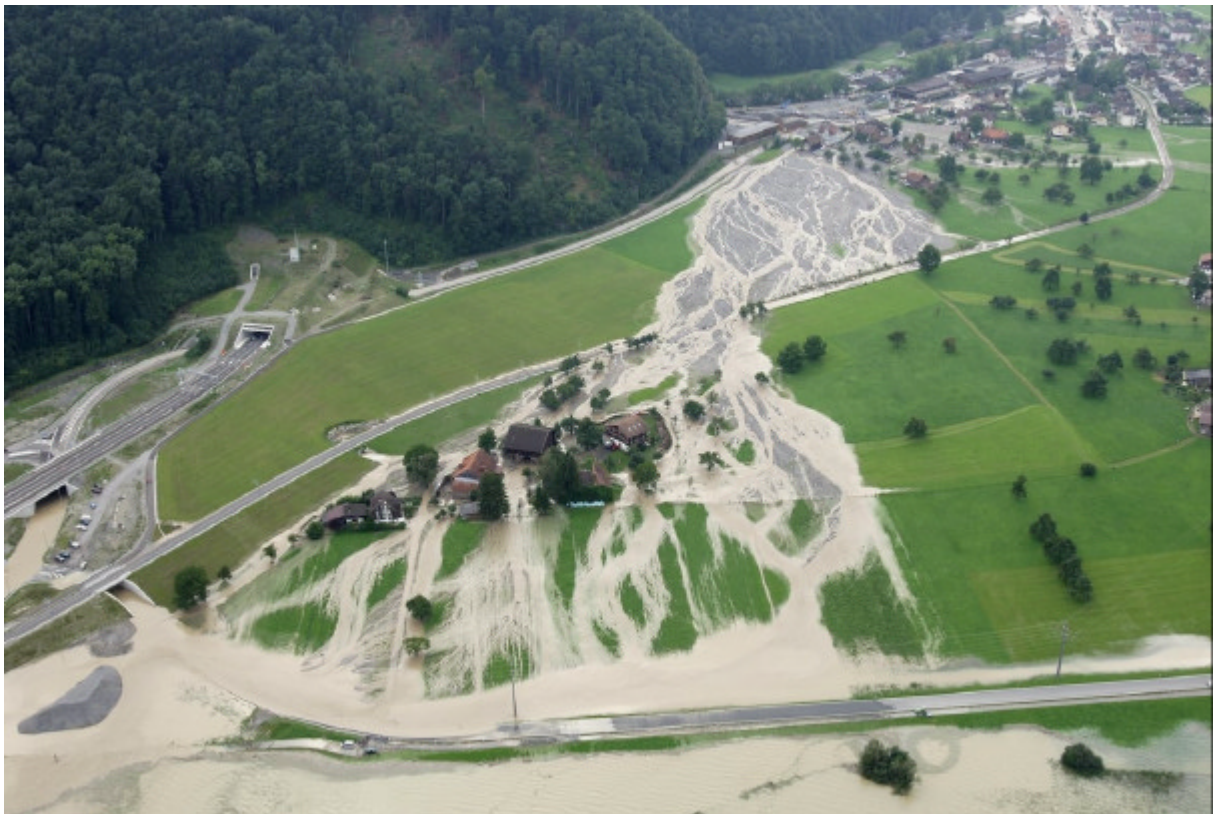
23.08.2005 – Giswil – Portal A8, Schwerzbachstrasse
