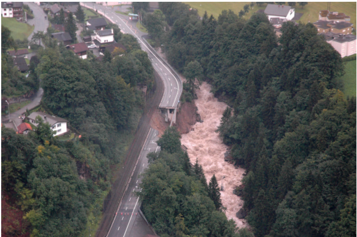
23.08.2005 – Engelberg – unterbrochene Bergstrasse
