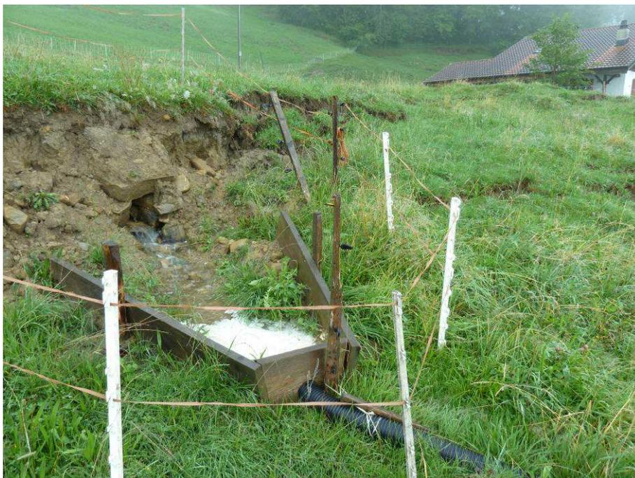
Abbildung 5: Provisorische Fassung eines Wasseraustritts im Müsli. Sie wird durch eine mit Weiden bestockte Abflussmulde ersetzt.
