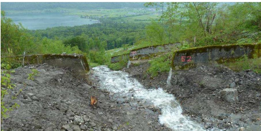
Abbildung 4: Absenken der Überfallkanten an einzelnen Sperren des Schlimbachs, damit das Wasser nicht in das abgesenkte Gelände neben dem Bach ausbrechen kann (teilweise bereits als Sofortmassnahmen ausgeführt).
