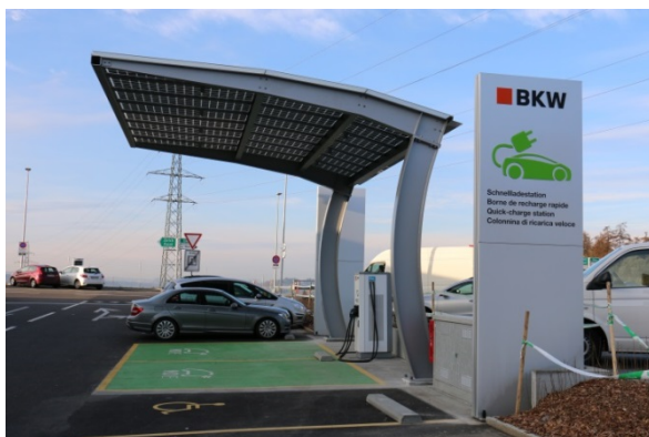
Abbildung 2: Schnellladestation mit PV-Anlage an der Autobahnraststätte Grauholz. Quelle: BKW
