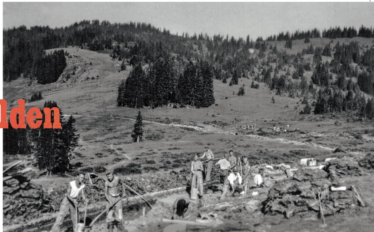
Polnische Internierte arbeiten an der Sattelstrasse in Giswil
