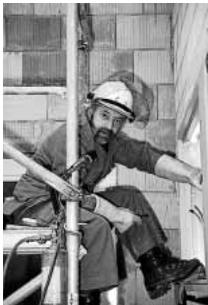
Erstellen eines Hausanschlusses
