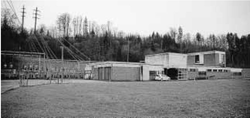
Unterwerk Sarnen: Drehscheibe der Stromversorgung
