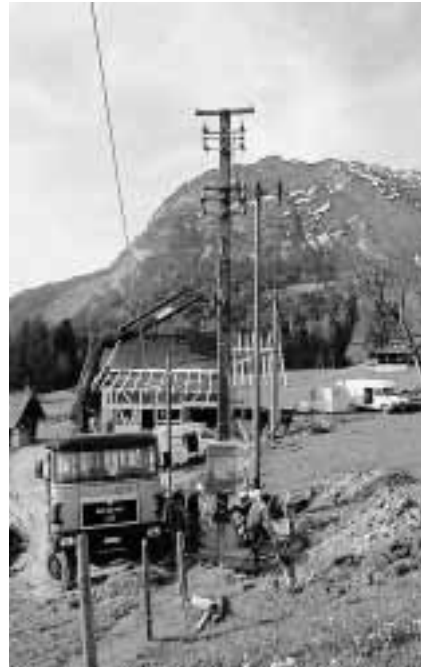
Bau einer Mast-Trafostation
