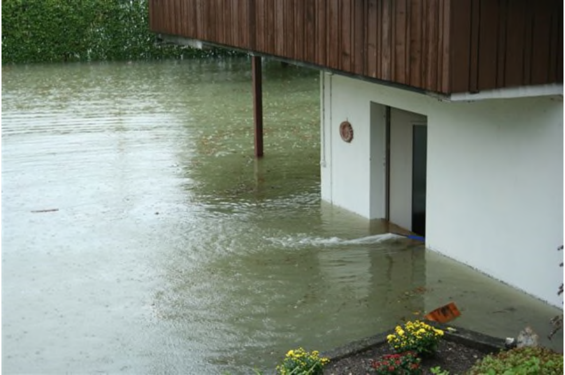
Bild: Hochwasser 2005, Kanton Obwalden
